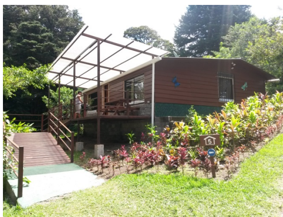
Imagen 1: Vista exterior de una cabaña
