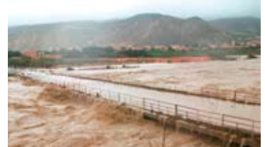
Inondations au niveau de l'Oued Souss ©photo : DRETL Souss Massa 2014
